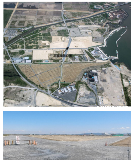
(工事地区現況)
