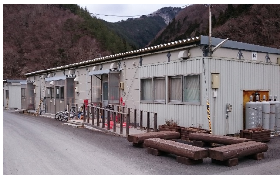
(簡易宿舎現況(釜石市))
