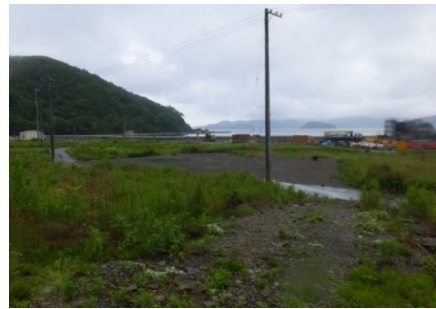
(工事地区現況)
