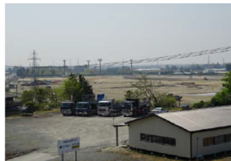
(造成工事の状況)
