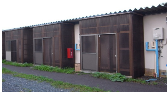
(簡易宿舎現況(宮古市))
