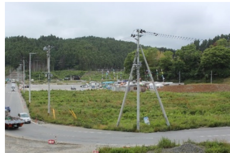
(工事地区現況)
